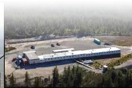
Camp de démarrage * fosse septique installée
